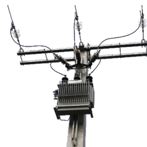
Transformateur électrique sur un poteau
